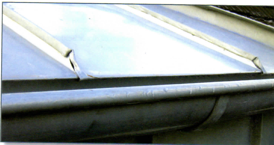
Echte Liebe zum Detail: Dieser „offene Stehfalz-Abschluss“ soll wohl in seiner Zusatzfunktion der Bewässerung des Daches dienen.
