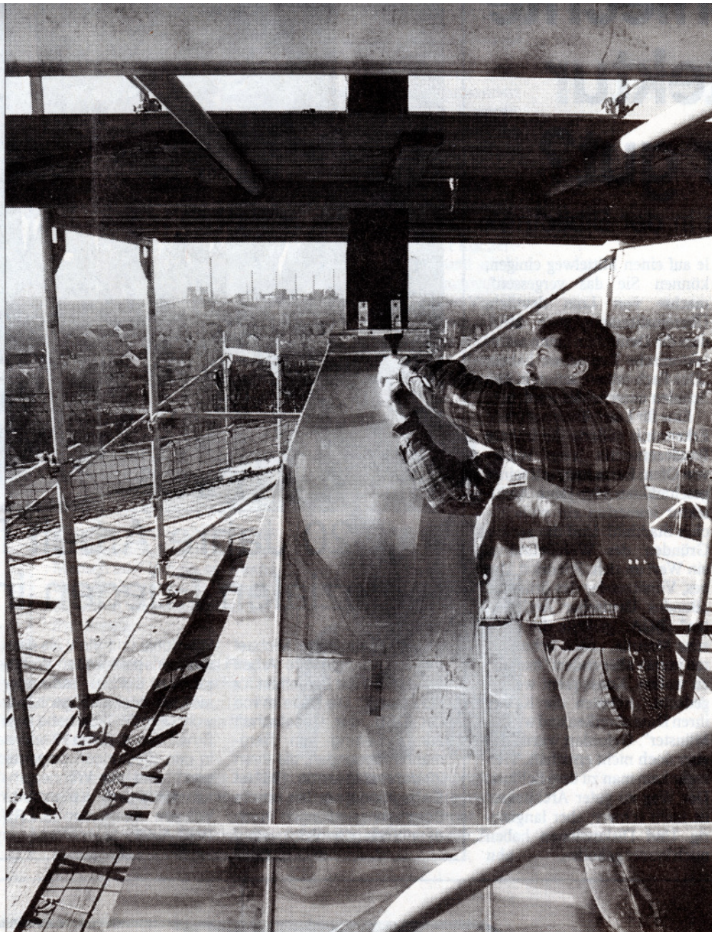
Im Moment wird an der Katernberger Kirche der Turm saniert. Dachdecker Dirk Keller arbeitet in 40 Metern Höhe am Kupferdach. Im Hintergrund: die Kokerei Zollverein. NRZ-Fotos: Ulrich von Born
